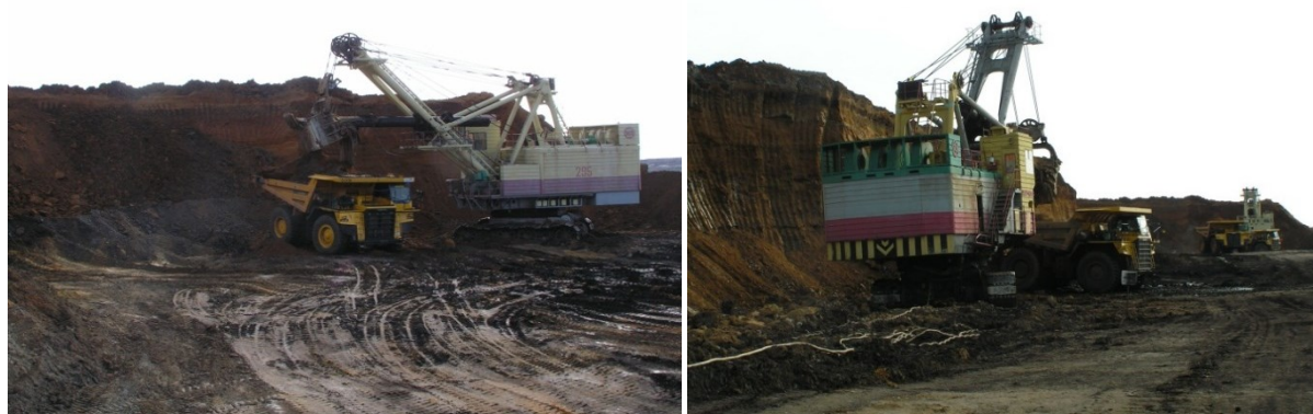
Рис. 1 – Вскрышные работы и автодорога
