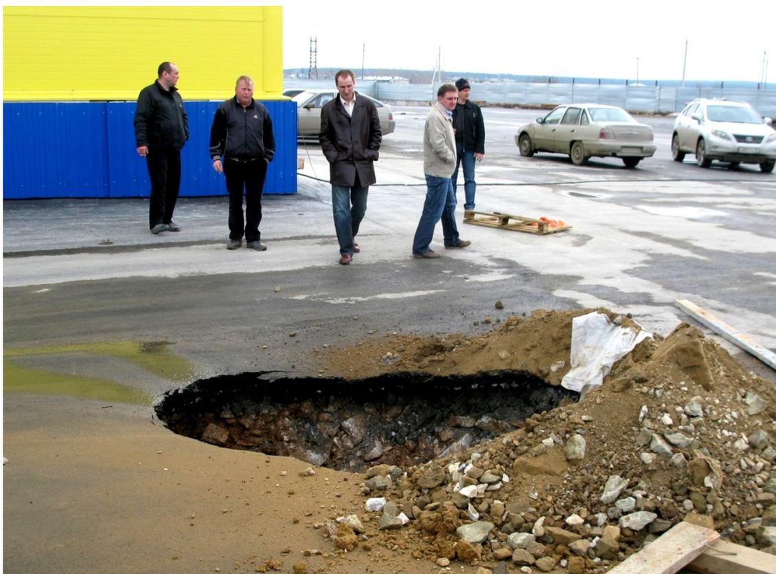
Рис. 2 – Территория г. Березовский. Образование провала над старательской горной выработкой. Горнотехническая документация по данной выработке отсутствует [2]
