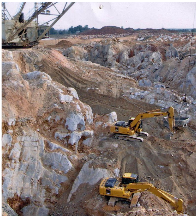
Рис. 1 – Отработка западин гидравлическими экскаваторами с обратной лопатой
