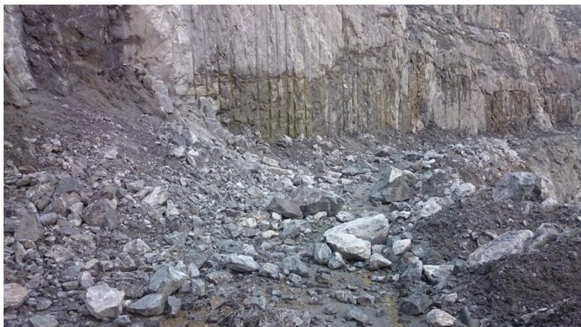
Рис. 3 – Состояние предохранительной бермы гор.+70 м до начала производства работ
