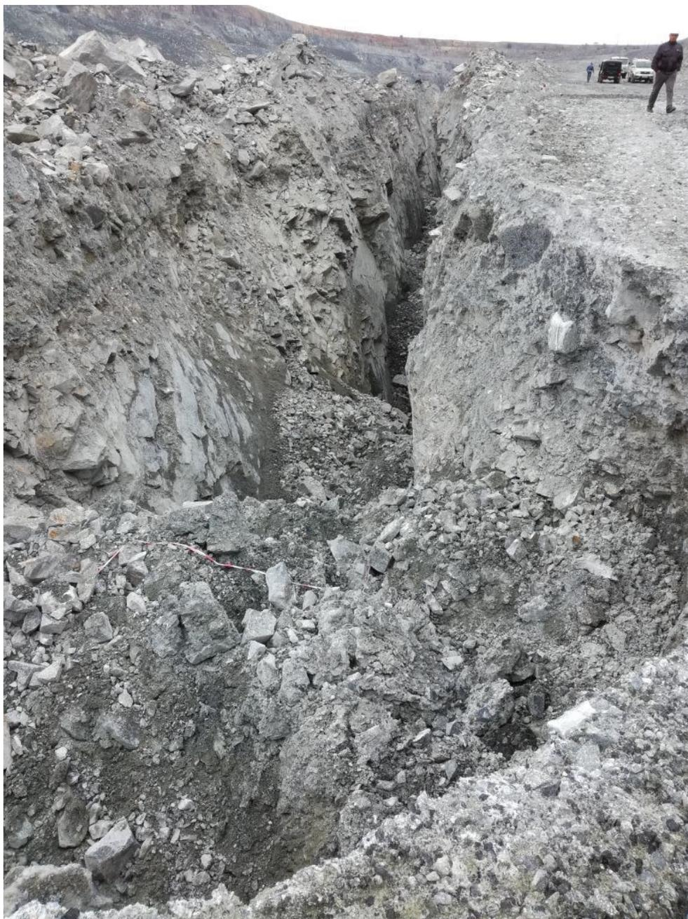
Рис. 3 – Характер нарушения борта карьера на участке концентрации сжимающих деформаций
