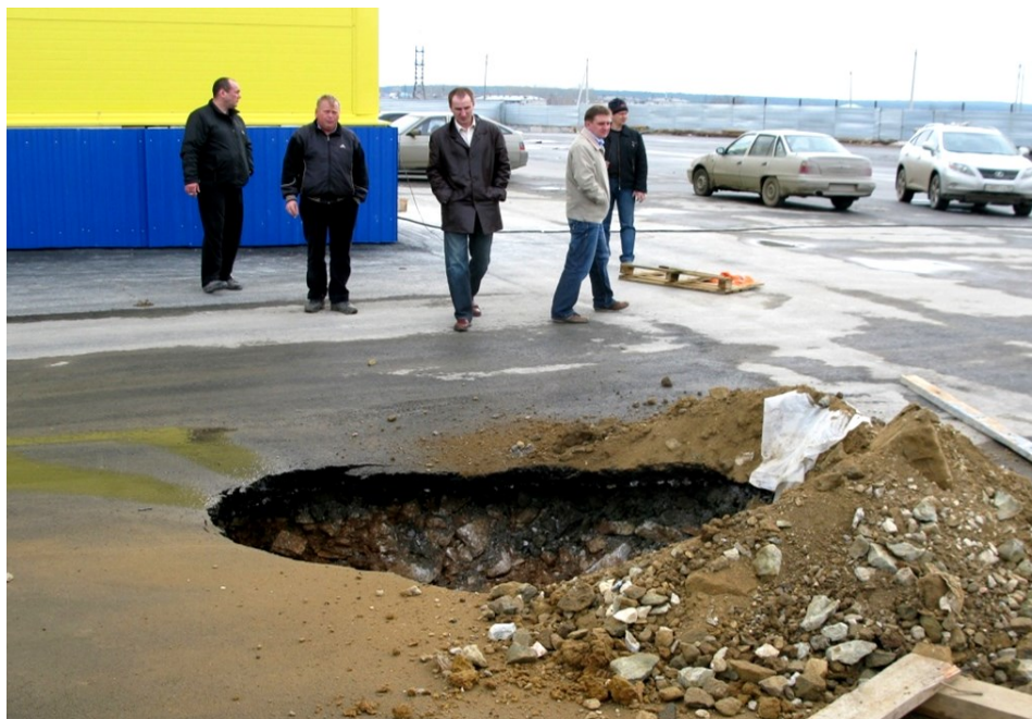
Рис. 2 – Образование провала над старательской горной выработкой на территории г. Березовский
