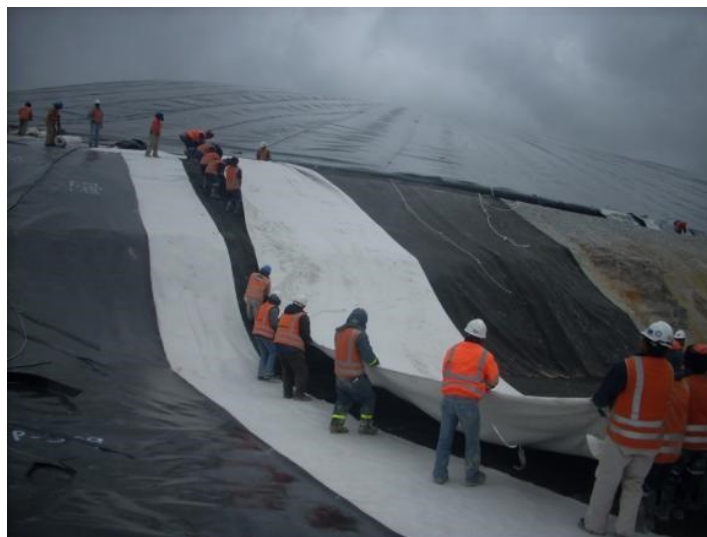
Рис. 5 – Установка геокомпозитов, геосинтетических глинистых экранов и геомембран
