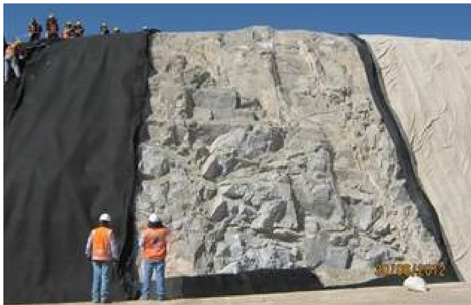
Рис. 7 – Скальная поверхность для размещения сетки
