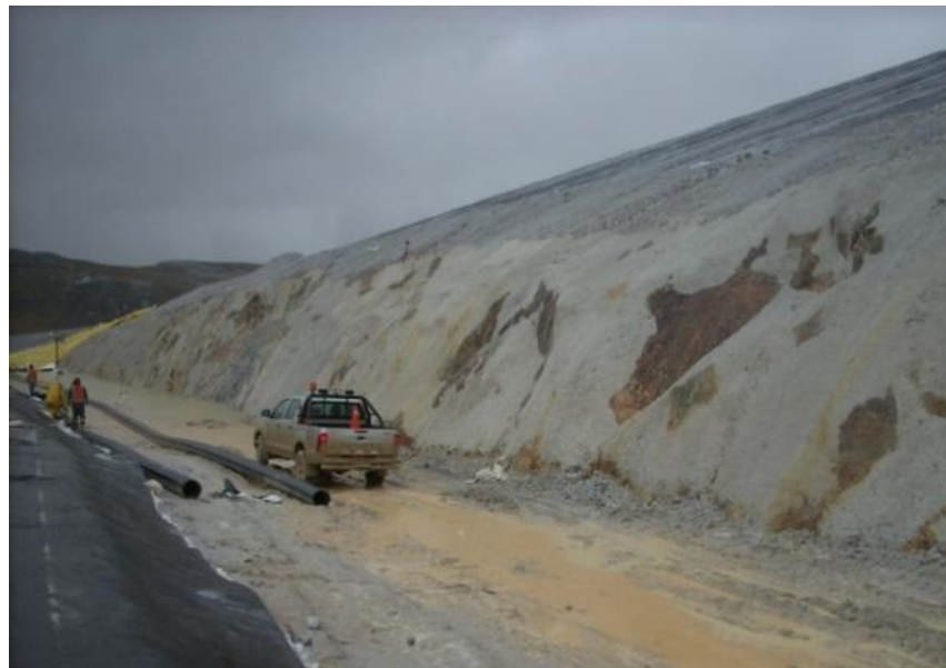
Рис. 4 – Подготовленная скальная поверхность до установки геосинтетических глинистых экранов или геомембран
