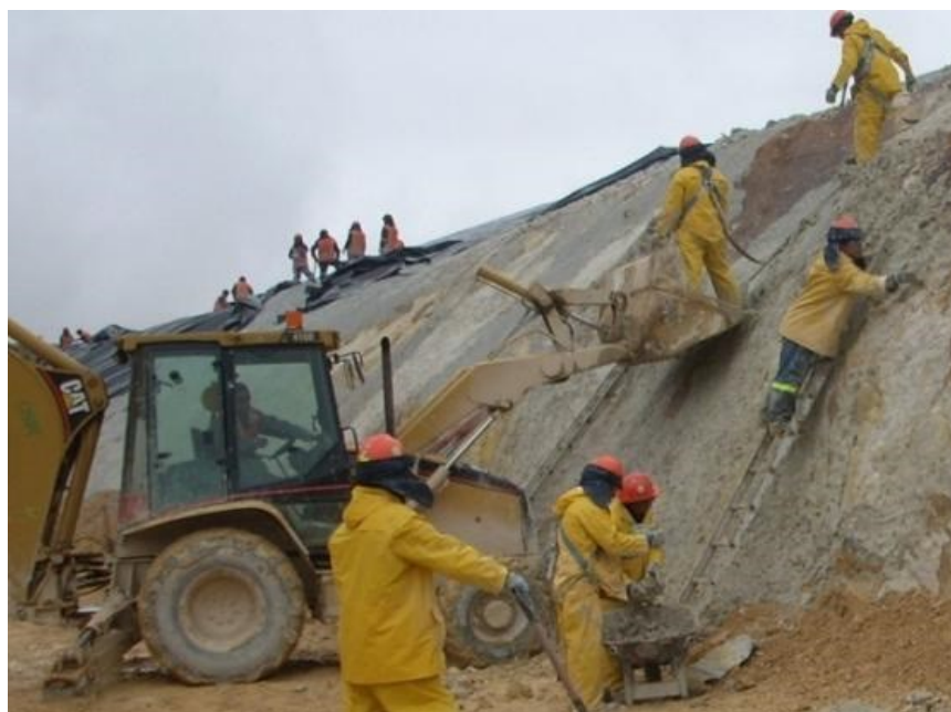
Рис. 2 – Подготовка поверхности перед установкой геосинтетических глинистых экранов и геомембран
