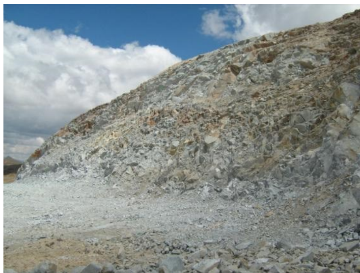
Рис. 6 – Вид склонов со скальными обнажениями, которые способны повредить геосинтетические глинистые экраны
