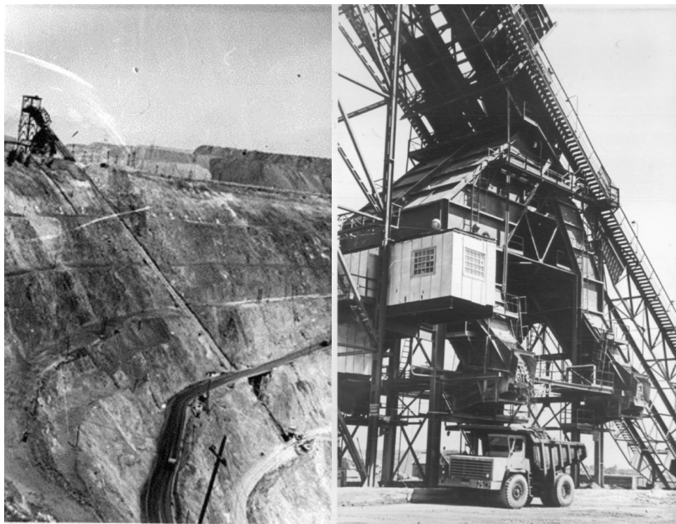
Рис. 2 – Трасса и разгрузочный пункт наклонного карьерного скипового подъемника на Сибайском карьере (фотоматериалы из архива ИГД УрО РАН)
