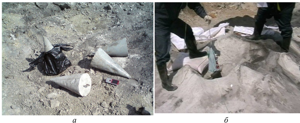
Рис. 4 – Закладные элементы ( а ) и размещение их в скважине ( б )
