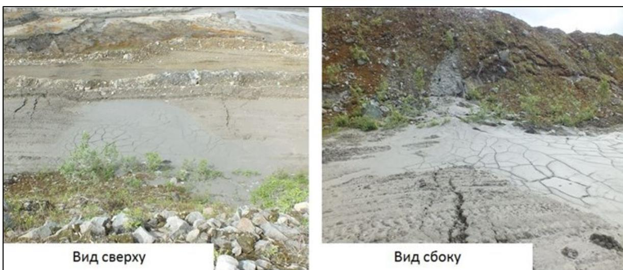
Рис. 1 – След суффозионного выноса материала дамбы
