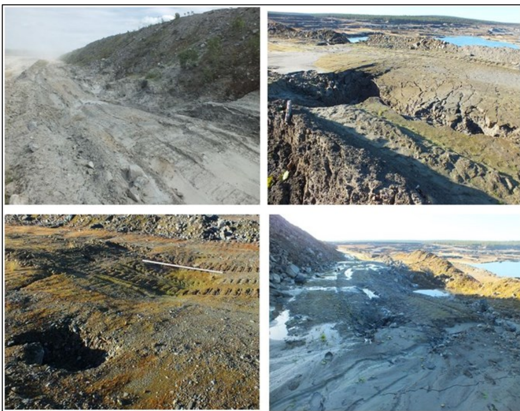
Рис. 3 – Локальные деформации поверхности полок ГТС
