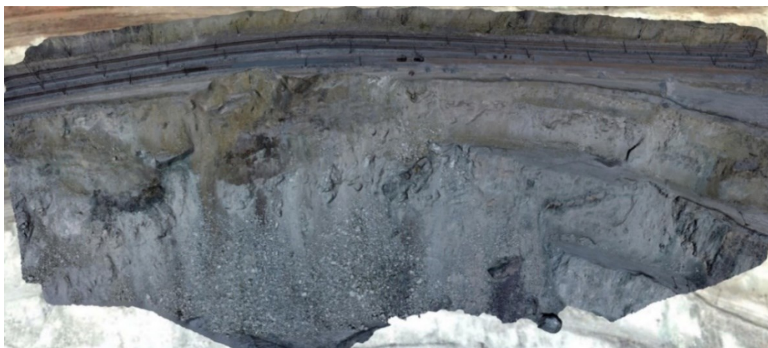
Рис. 1 – Нарушенный участок западного борта Кiemбаевского карьера
