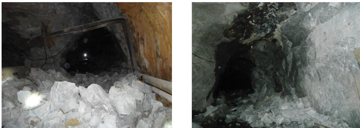
Рис. 1 – Разрушения горных выработок в результате горного удара 06.04.2016 на Николаевском полиметаллическом месторождении
