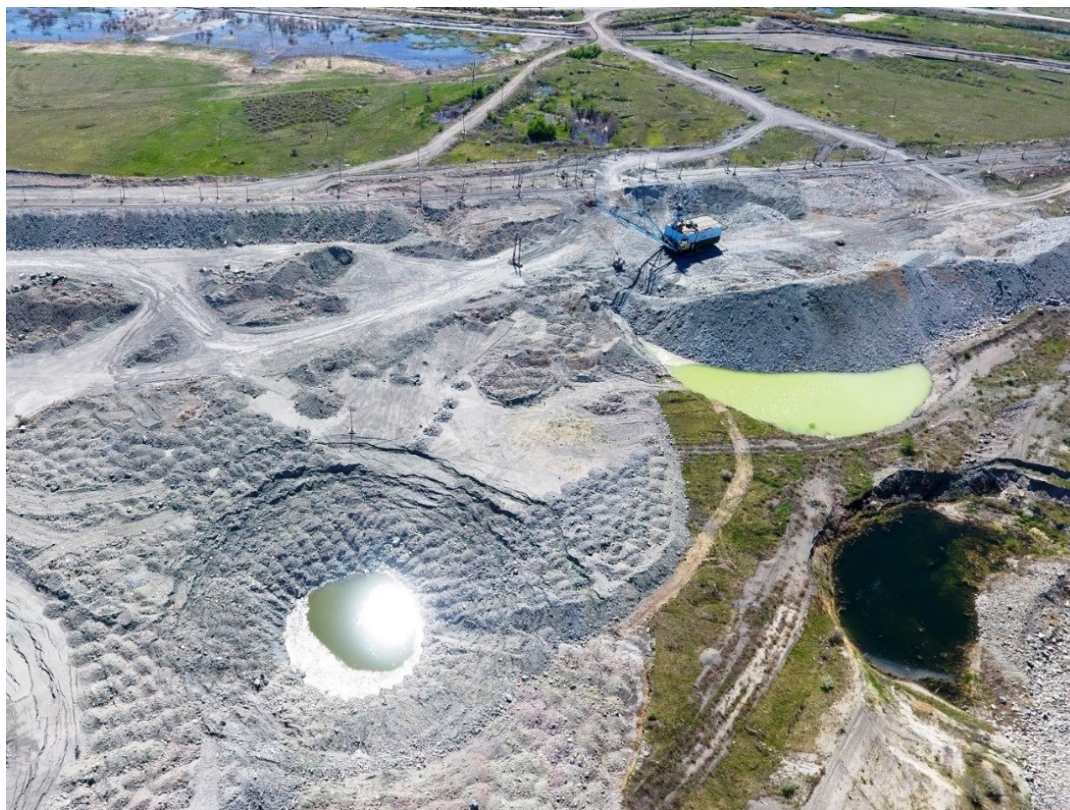
Рис. 2 – Засыпка воронок в зоне обрушения шахты Соколовская
