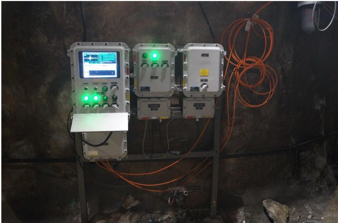
Рис. 1 – Взрывозащищенный коммутационно-распределительный узел автоматизированной системы «Prognoz-ADS»
