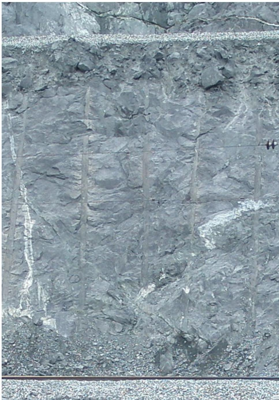
Рис. 3 – Поверхность откоса 15-метрового уступа со следами скважин отрезной щели
