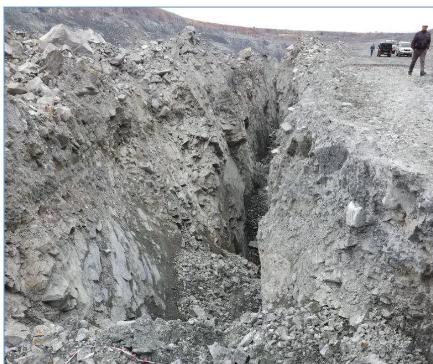
Рис. 4. Раскрытие трещины в 2017 г.
