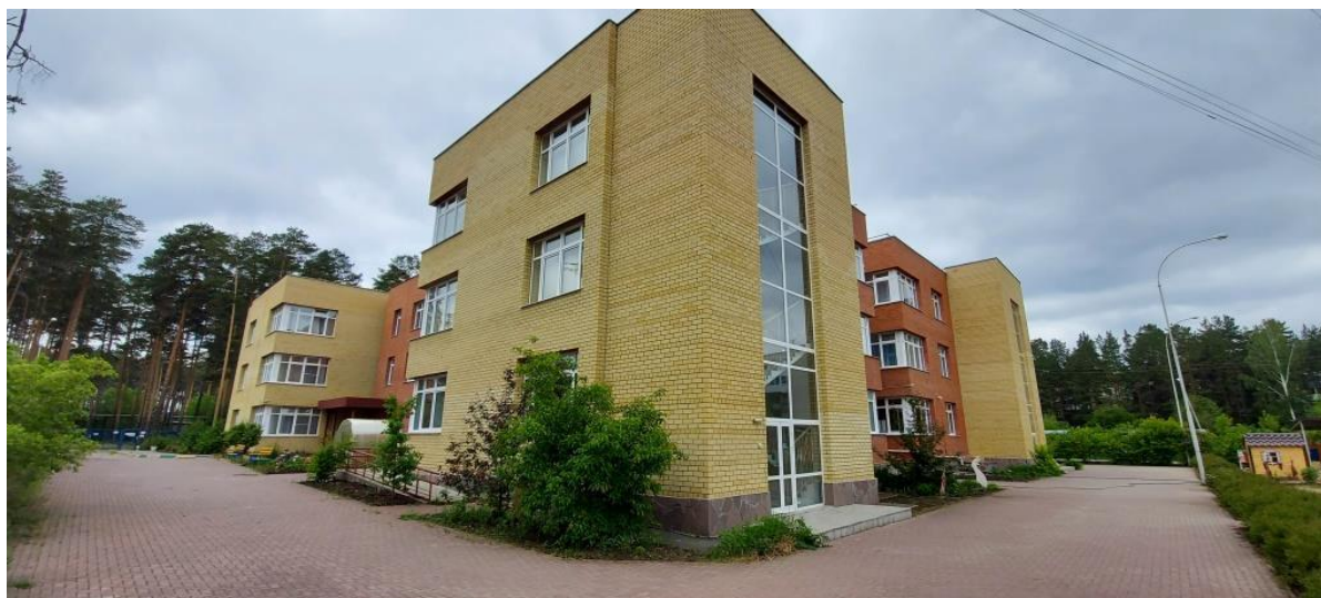
Рис. 1. Здание на территории залегания подземных горных разработок
