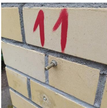
Рис. 4. Стенной репер наблюдательной станции
