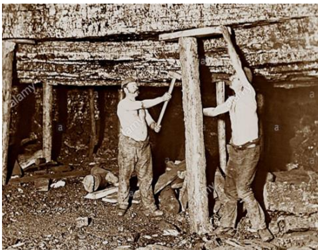
Рис. 1. Крепление горных выработок деревянными стойками
