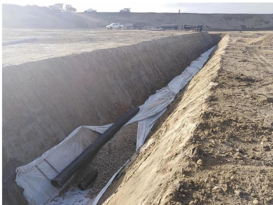
Рис. 7. Укладка дренажной системы.
