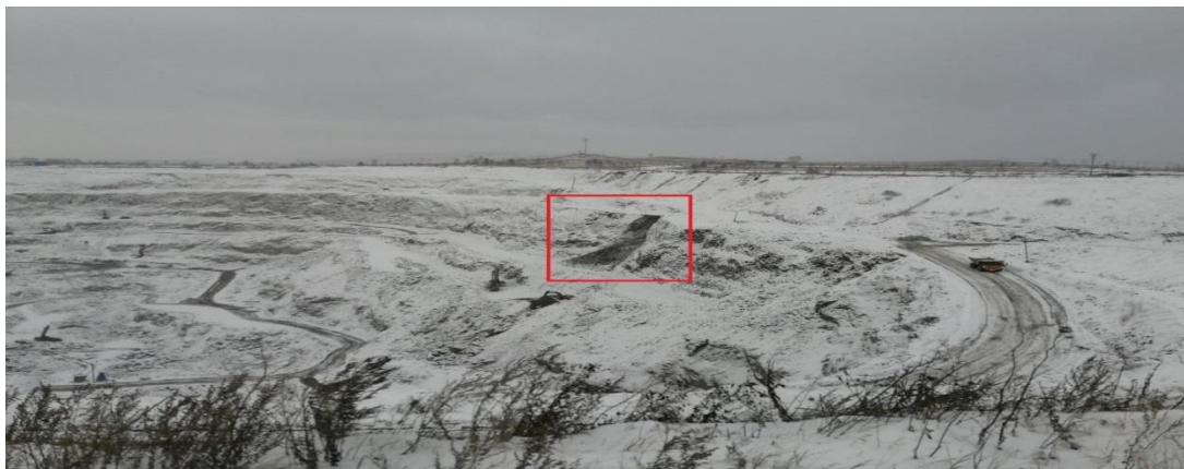
Рис. 2. Деформации восточного борта в отметках 470 – 420 м в октябре 2019 г.
