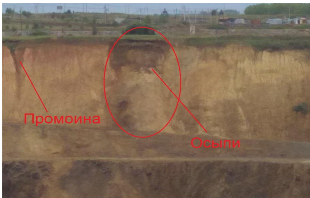
Рис. 1. Деформации верхнего уступа восточного борта в августе 2019 г.
