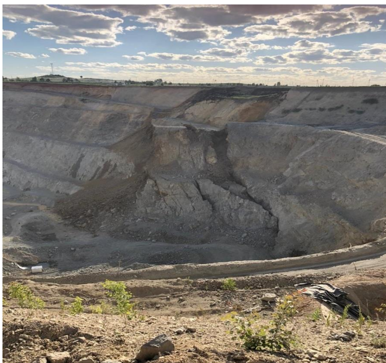
Рис. 3. Деформации юго-восточного борта в отметках 504 – 400 м
