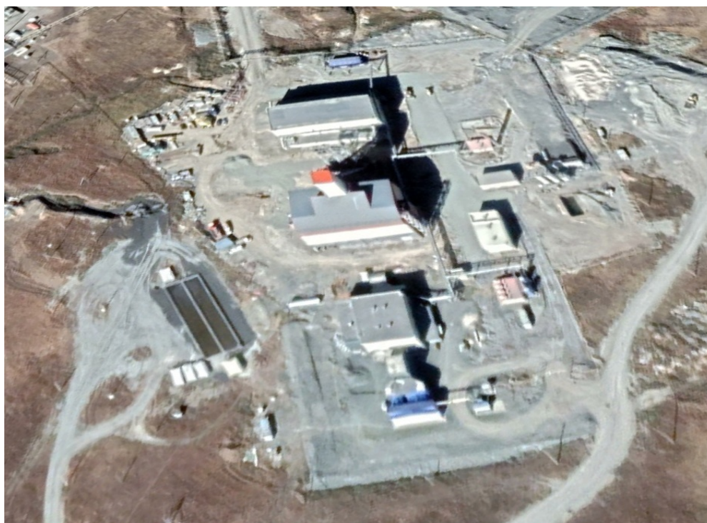
Рис. 2. Вид строительной площадки шахтного ствола (Гугл Земля)
