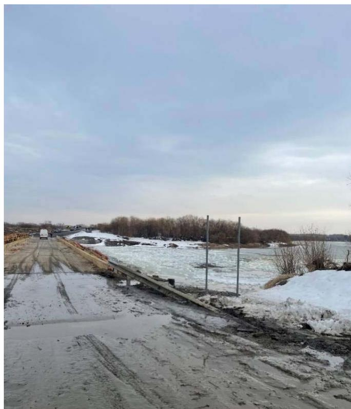
Рис. 5. Общий вид моста и получившейся майны
