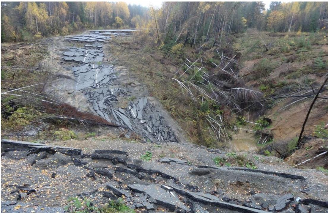
Рис. 5 – Образование зоны обрушения над Южной залежью в депрессионной зоне (октябрь 2013 г.)
