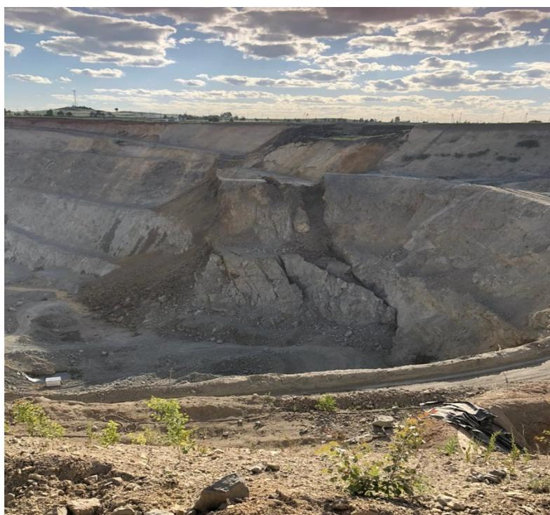
Рис. 3. Деформации юго-восточного борта в отметках 504 – 400 м
