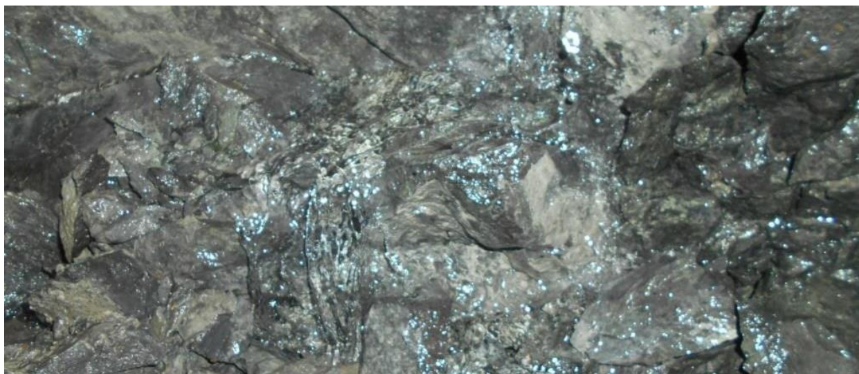
Рис. 2. Обводненность и отслаивание стенок выработки
