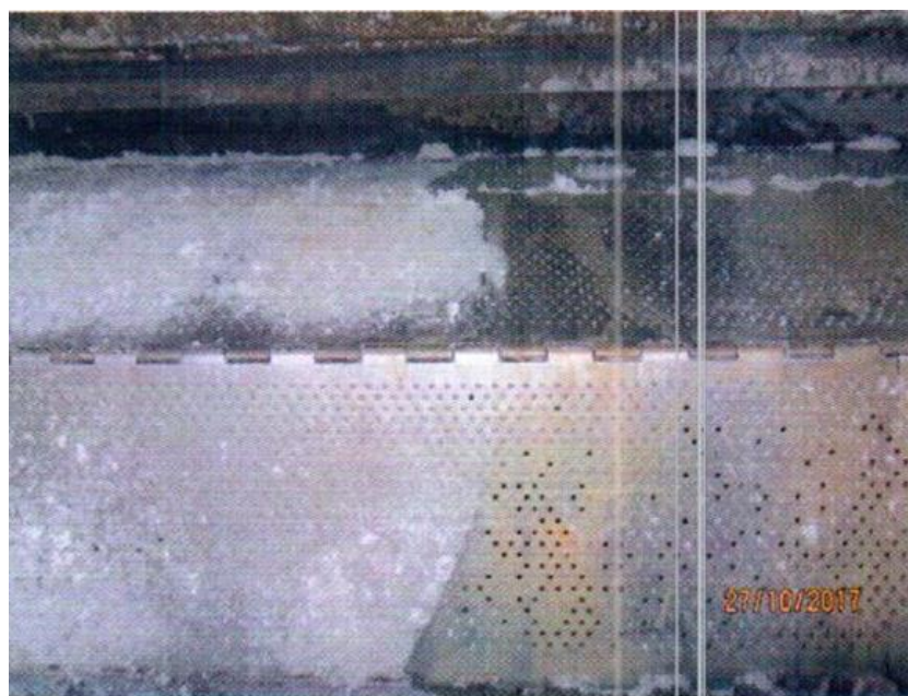
Рис. 2. Внешний вид оборудования сушильного агрегата: слева – необработанная поверхность; справа – обработанная антиадгезивом
